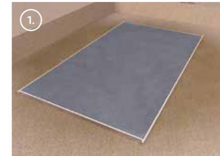
1. Couler la dalle en béton avec Treillage métal 8/8/150/150
